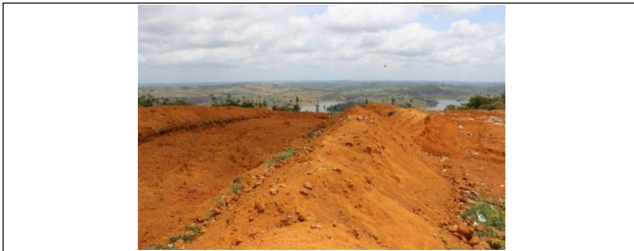
Fig. 16: Destino final de RSU em Tucuruí, classificado como lixão a céu aberto. Aspecto ordenado e com cobertura. (BRENCORP, 2012).
