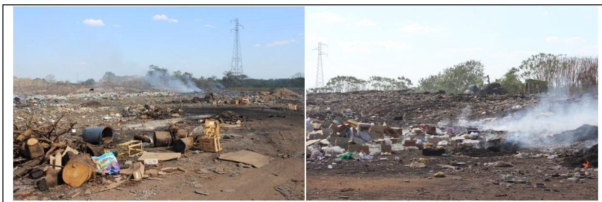
Fig. 4. Destino final de RSU Redenção: Classificado como lixão, proximidade a linha de alta tensão, combustão da massa de lixo, aspecto desordenado, ausência de cobertura regular da massa de lixo (BRENCORP, 2012).
