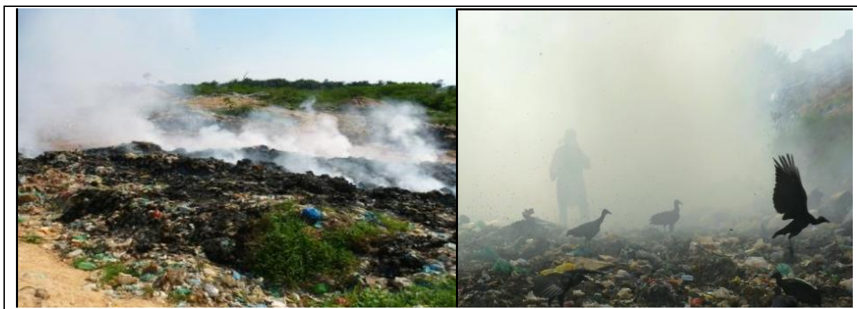
Fig.10: Destino final de RSU em Itaituba, classificado como lixão a céu aberto. Combustão da massa de lixo, aspecto desordenado, ausência de cobertura regular da massa de lixo, presença de catadores e aves (BRENCORP, 2012).
