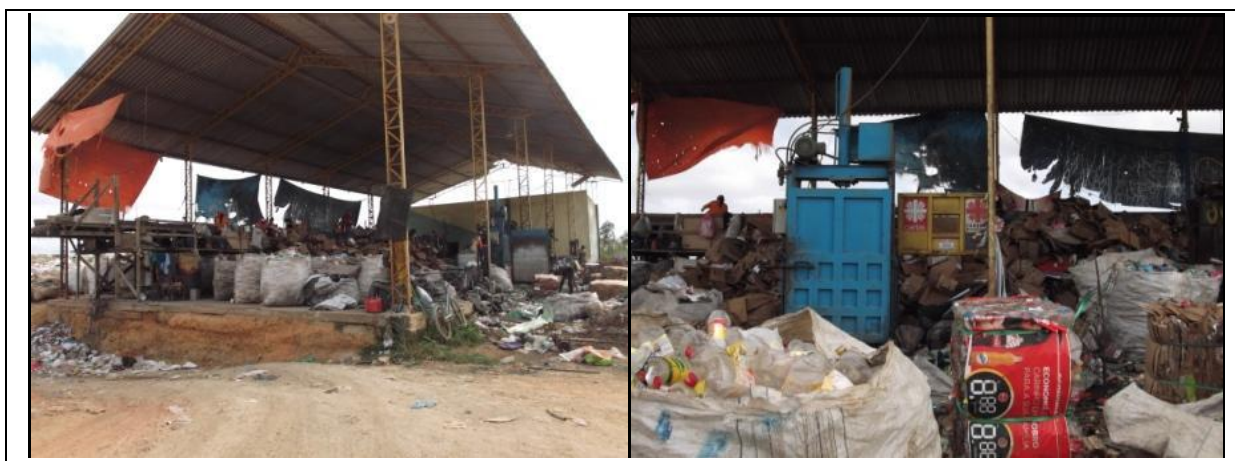
Fig. 30. Galpão de triagem da Cooperativa de Materiais Recicláveis de Paragominas (COOPERCAMARI) (esq.). Interior do galpão com prensa hidráulica e materiais separados (dir.). (BRENCORP, 2012).
