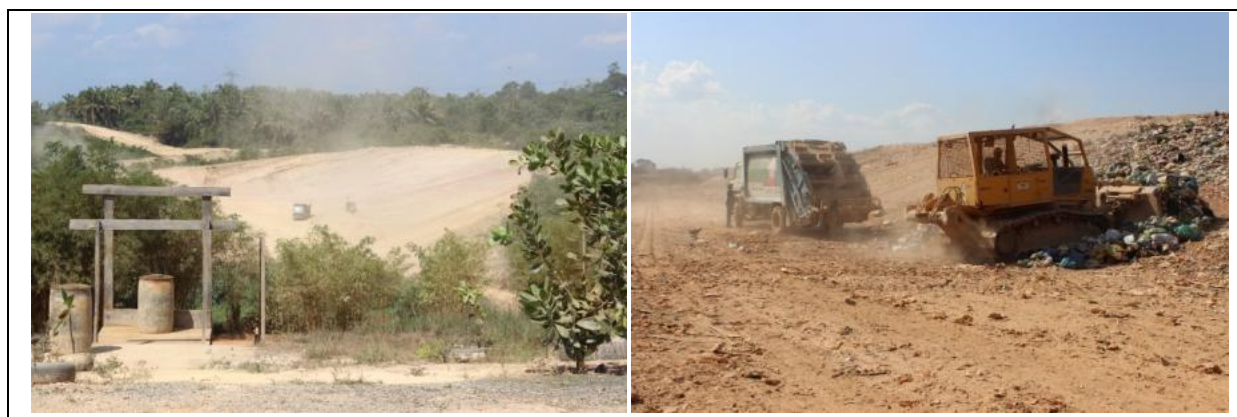
Fig. 12: Destino final de RSU em Marabá, classificado como aterro sanitário emergencial: Vista geral da área ampliada (esq.), compactação e cobertura regular da massa de lixo (dir.) (BRENCORP, 2012).
