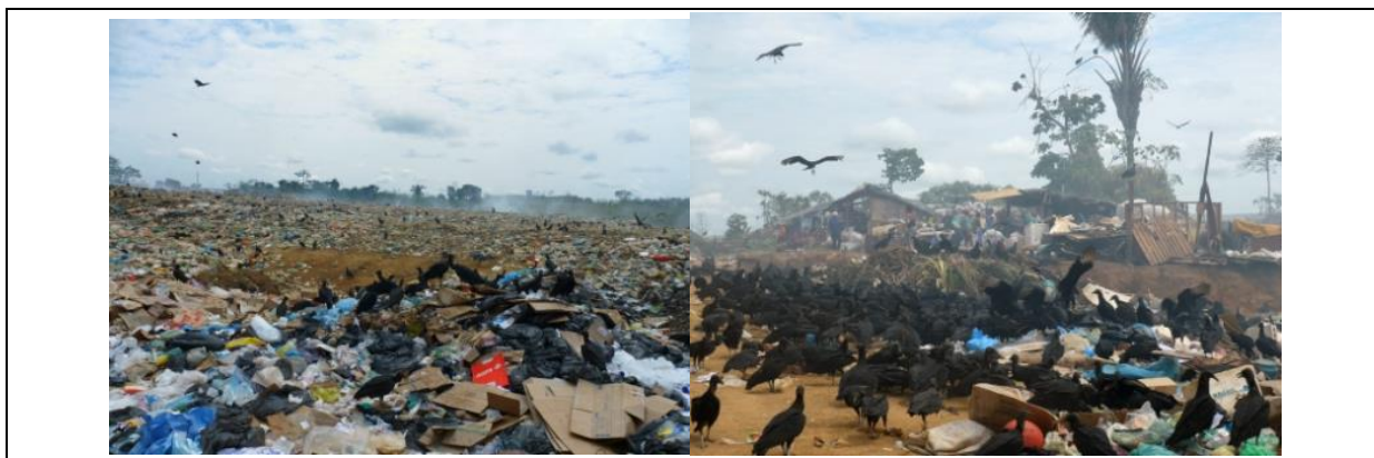
Fig. 27: Destino final de RSU em Altamira, classificado como lixão a céu aberto: Combustão da massa de lixo, aspecto desordenado, ausência de cobertura regular da massa de lixo (esq.). Presença de catadores e aves (dir.) (BRENCORP, 2012).
