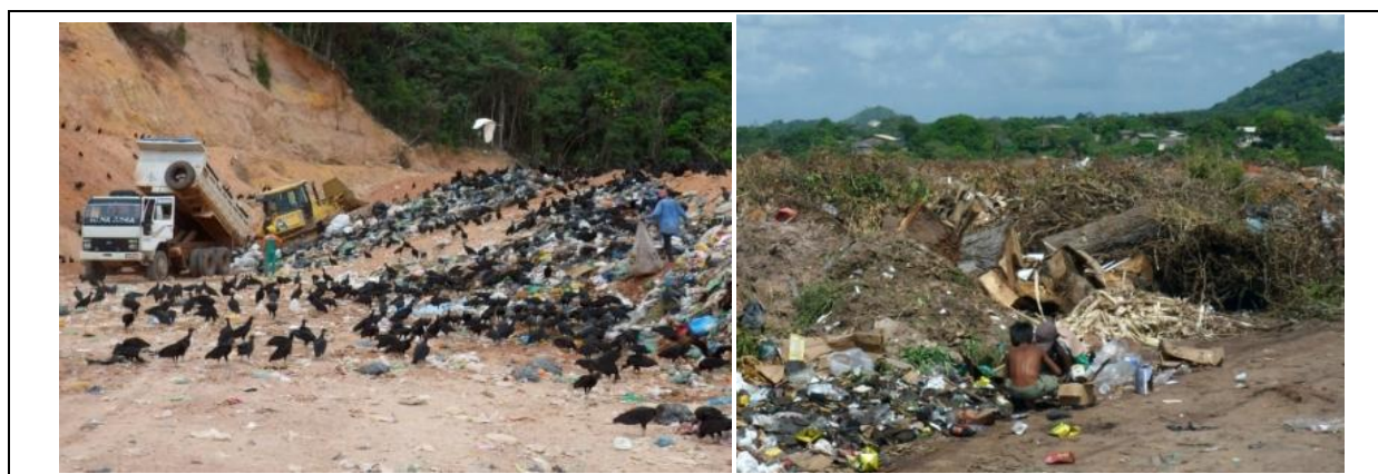
Fig. 7. Destino final dos RSU de Santarém, classificado como aterro controlado. Presença de esteira e cobertura regular. Presença de catadores e aves (esq.). Bota fora Santo André, informado para receber RCD e materiais inertes. Presença de crianças (dir.) (BRENCORP, 2012).
