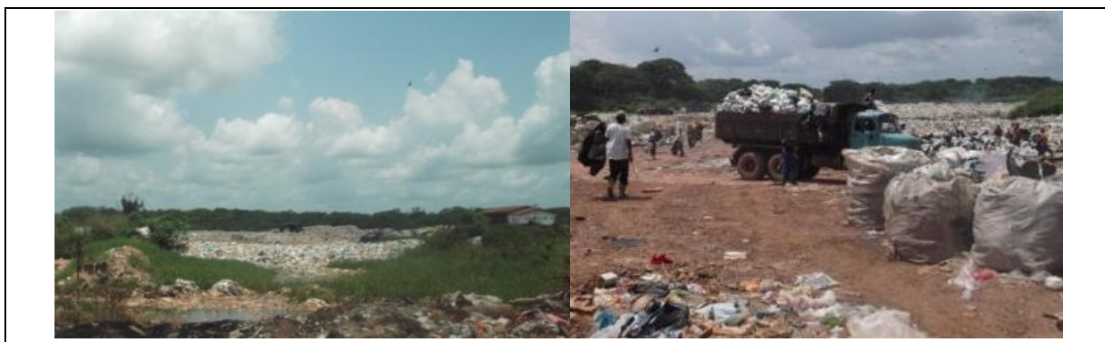
Fig. 15: Destino final de RSU em Castanhal, classificado como lixão a céu aberto. Aspecto desordenado, ausência de compactação e de cobertura regular da massa de lixo, presença de catadores (BRENCORP, 2012)
