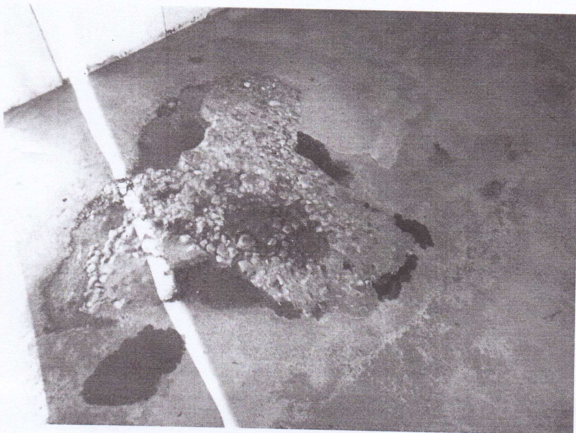
Imagem 16: piso da sala de abate.
