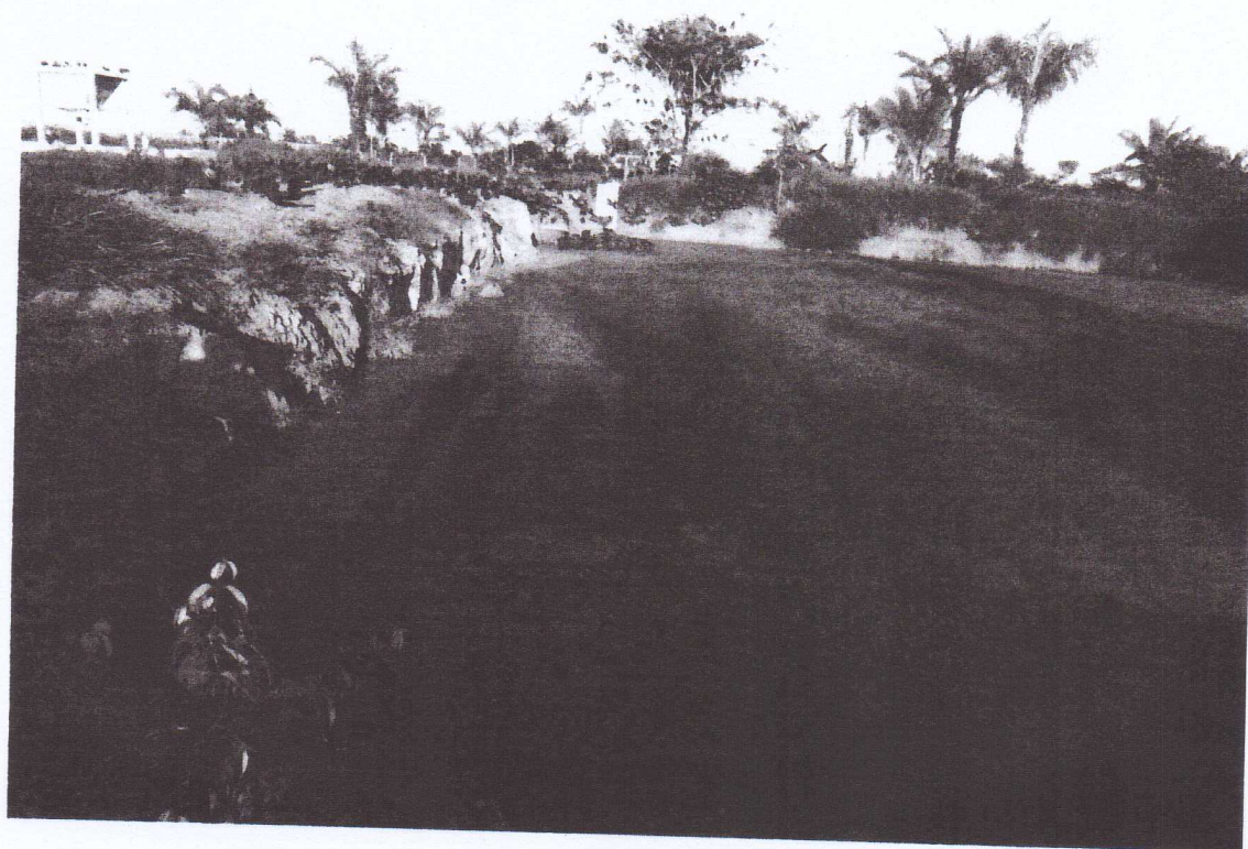
Imagem 5: Lagoa de estabilização esgotada.
