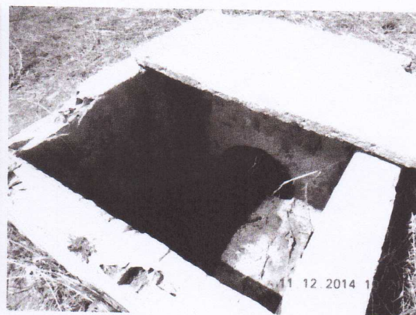
Figura 2 e 3: Caneletas e caixa de passagem de águas pluviais.
