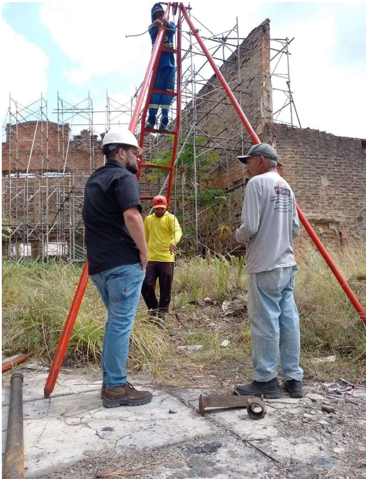
Foto 1 – Montagem da Sonda no Furo SP01
