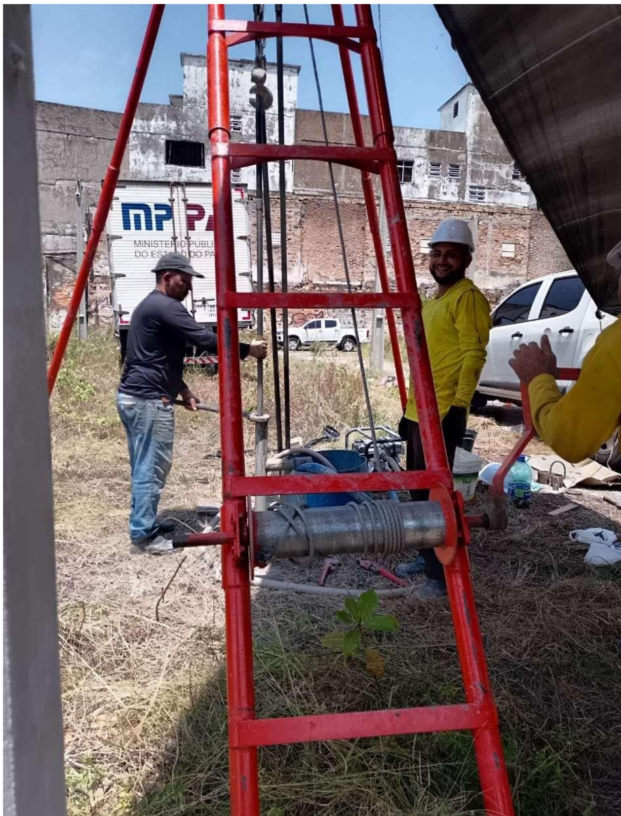
Foto 1 – Montagem da Sonda no Furo SP02
