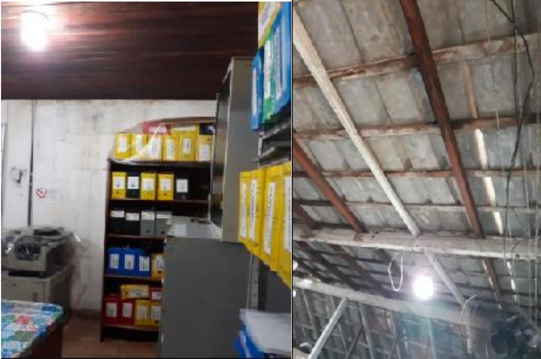
Portanto, resta flagrante que as condições estruturais da Escola Estadual Silvestre Carneiro encontram-se visivelmente depreciadas e comprometidas, necessitando de urgente reforma estrutural, em sua edificação, no telhado, na rede hidráulica e sobretudo na rede elétrica, que neste período de inverno amazônico, tem sua fiação exposta ao contato com a umidade que brota das goteiras que existem no lugar.
